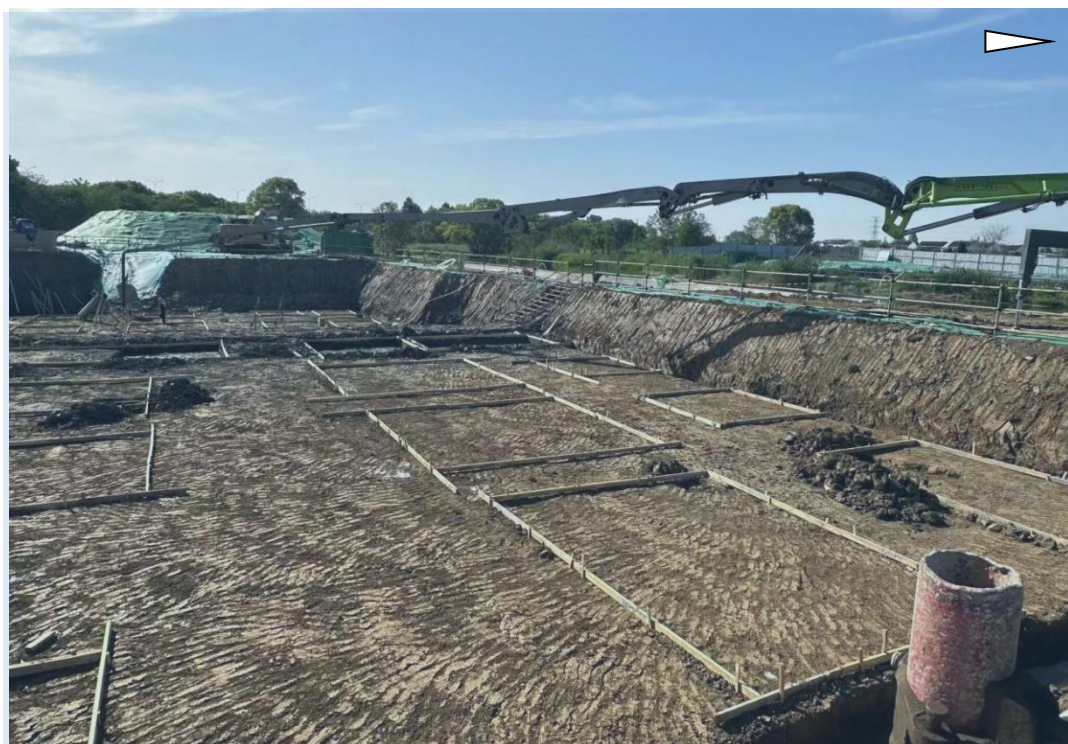
图 2.1-10 工程现状现场照片（2025 年 4 月）
