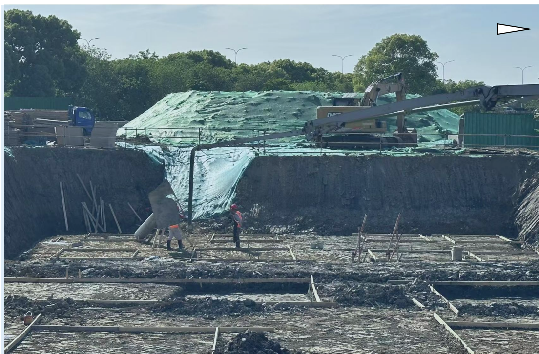
图 2.1-9 工程现状照片图（2025 年 4 月）
