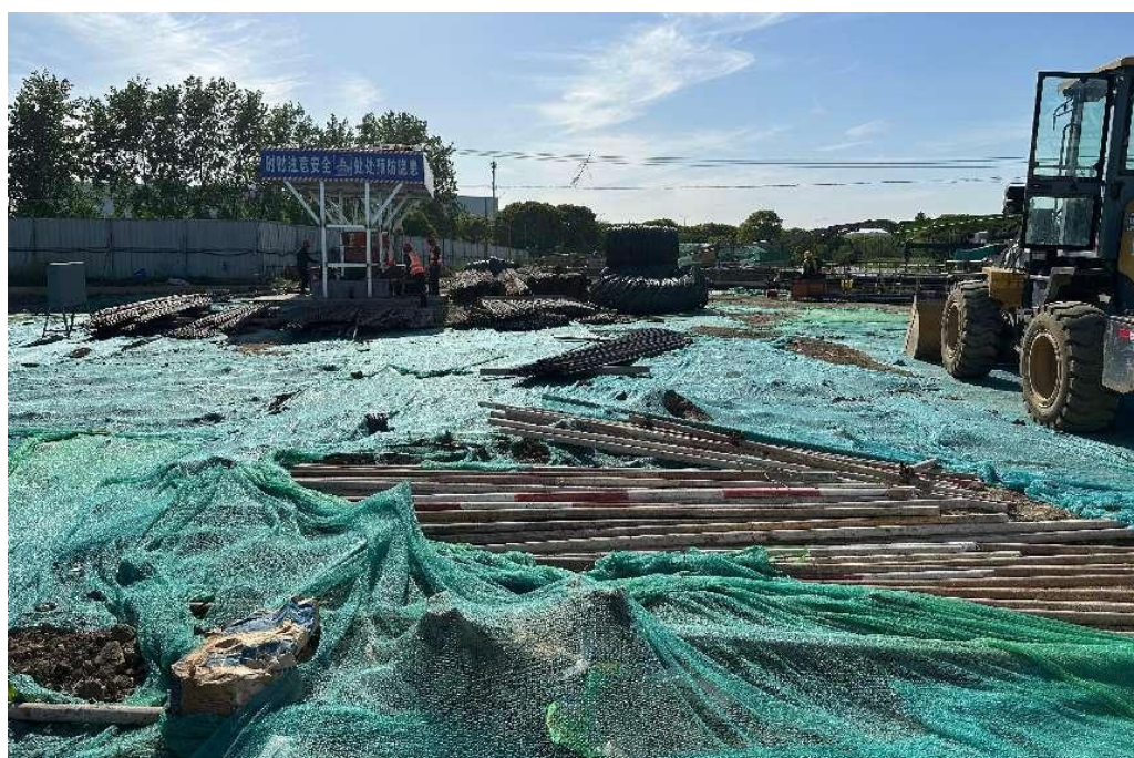
图 2.2-2 施工场地（2025 年 4 月）
