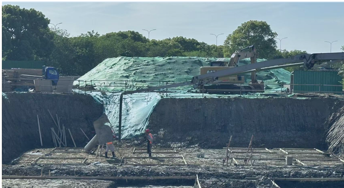
图 3.4-1 堆土区现场照片（2025 年 4 月）
