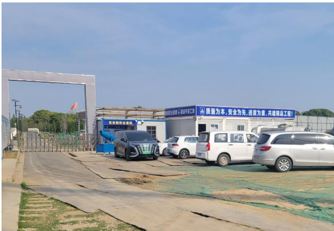
图 2.2-3 临时办公生产区（2025 年 4 月）
