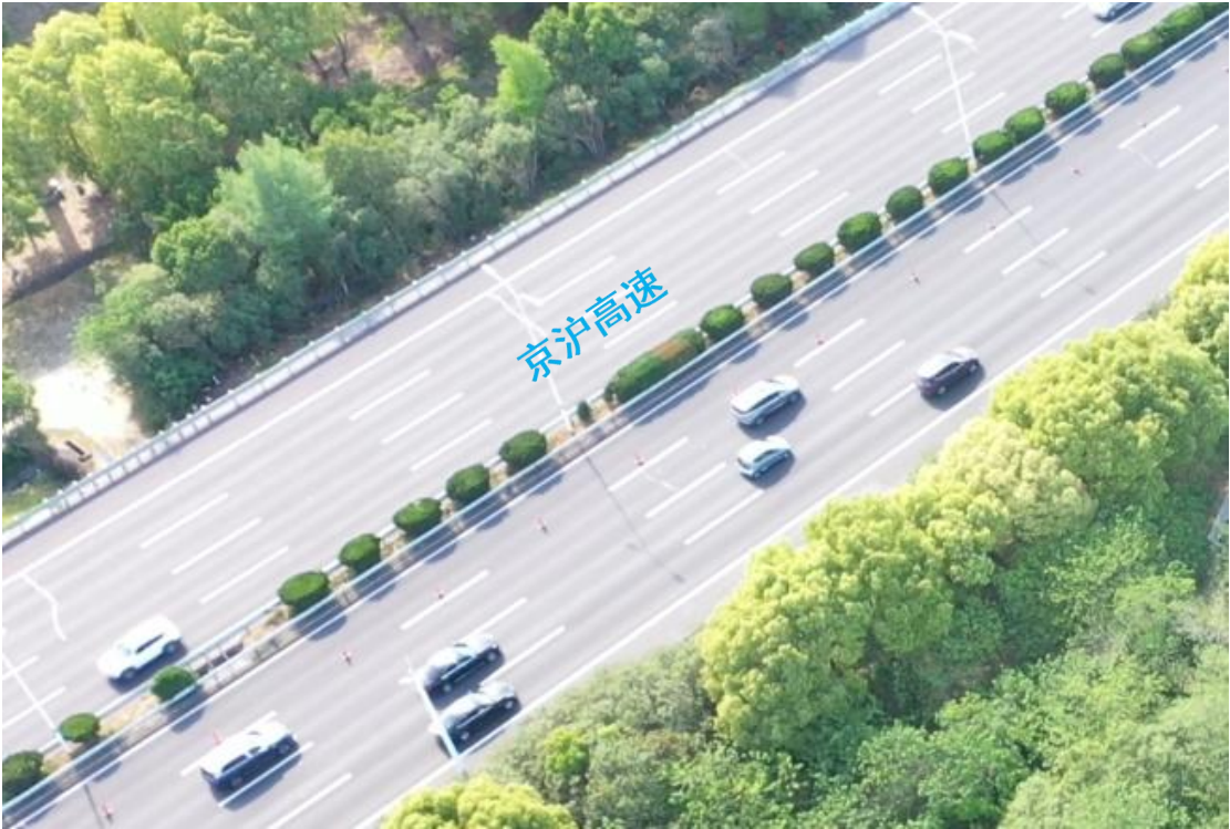
图 2.1-12 项目区周边情况-西侧京沪高速（2025 年 4 月）
