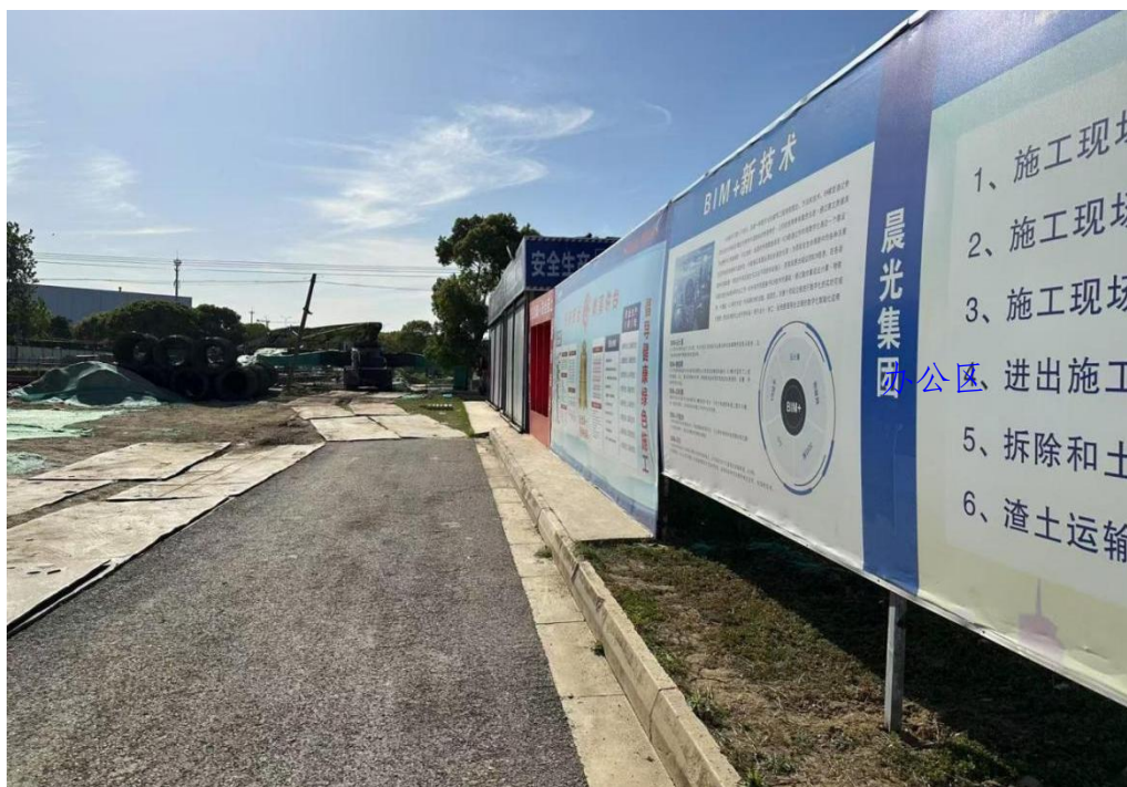
图 2.2-1 施工场地（2025 年 4 月）
