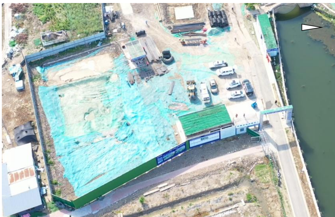
图 2.2-1 临时办公生产区（2025 年 4 月）
