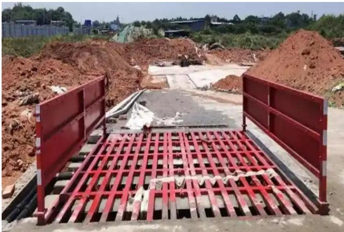
图3.5-1 临时措施图（洗车平台）
