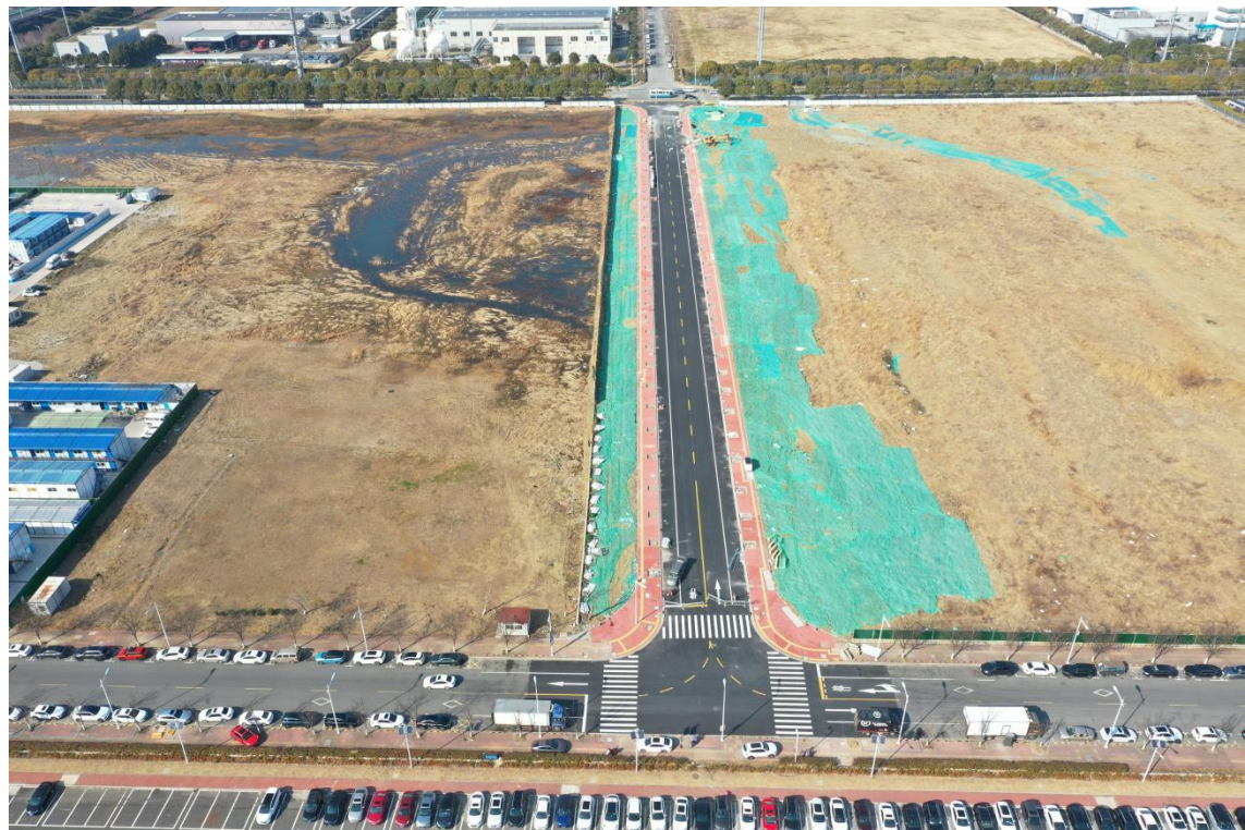
(b) 现场航拍图 2025 年 2 月
