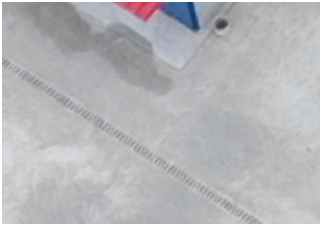
b) 临时排水沟
