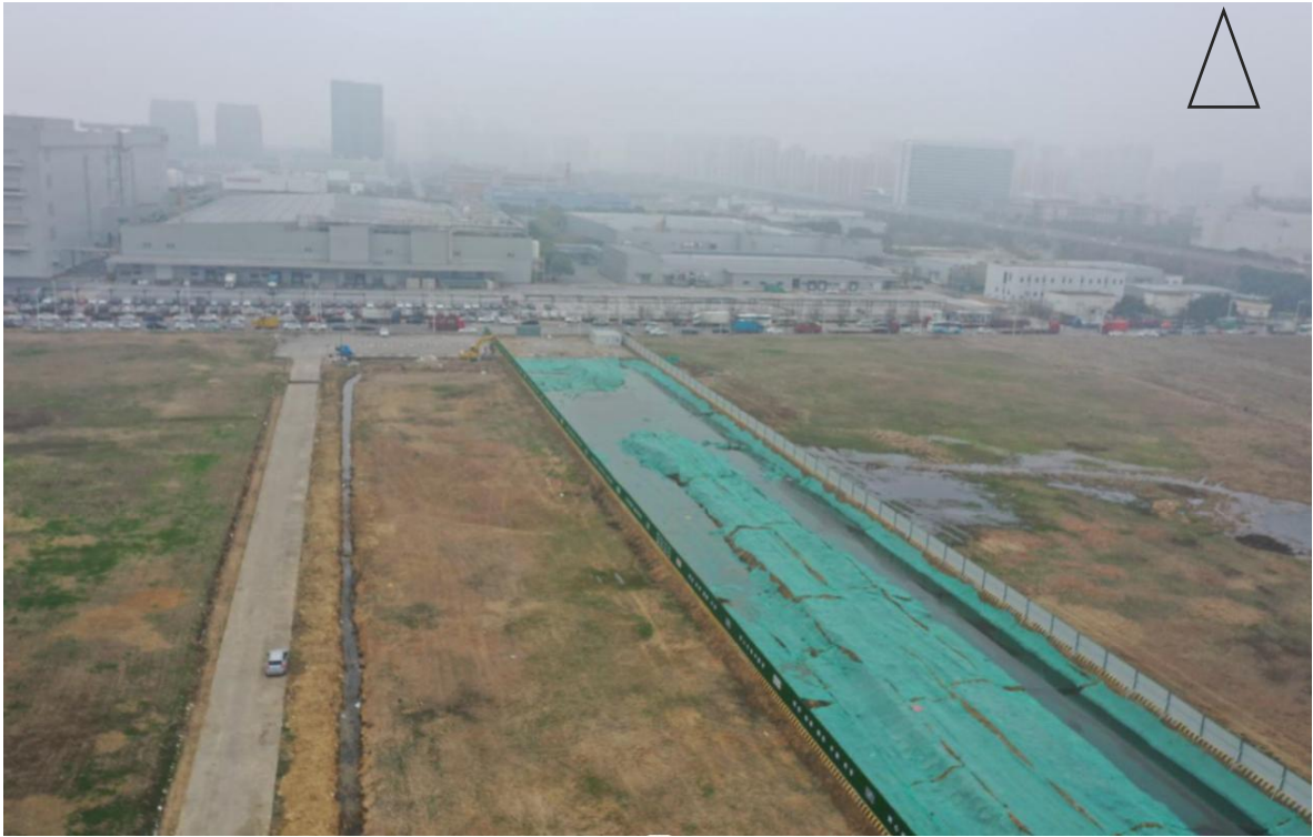
(a) 现场航拍图 2024 年 4 月
