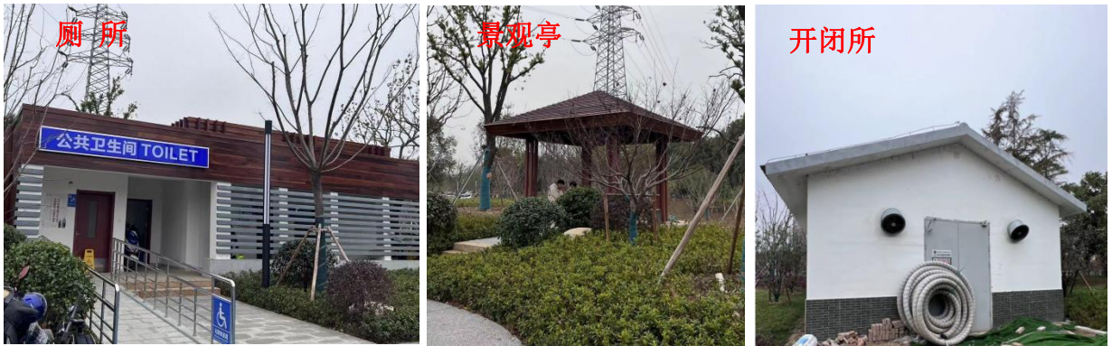
图 2.1-7 建筑物现场照片
