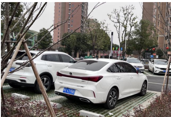
(e) 透水铺装 (2024.2)
