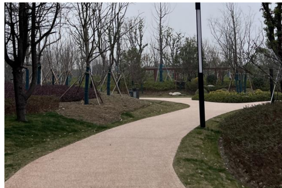
(b) 透水铺装 (2024.2)
