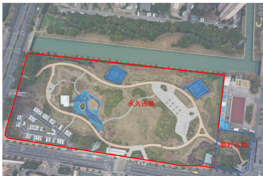
图 2.2-2 施工后现状航拍图（2024 年 2 月）
