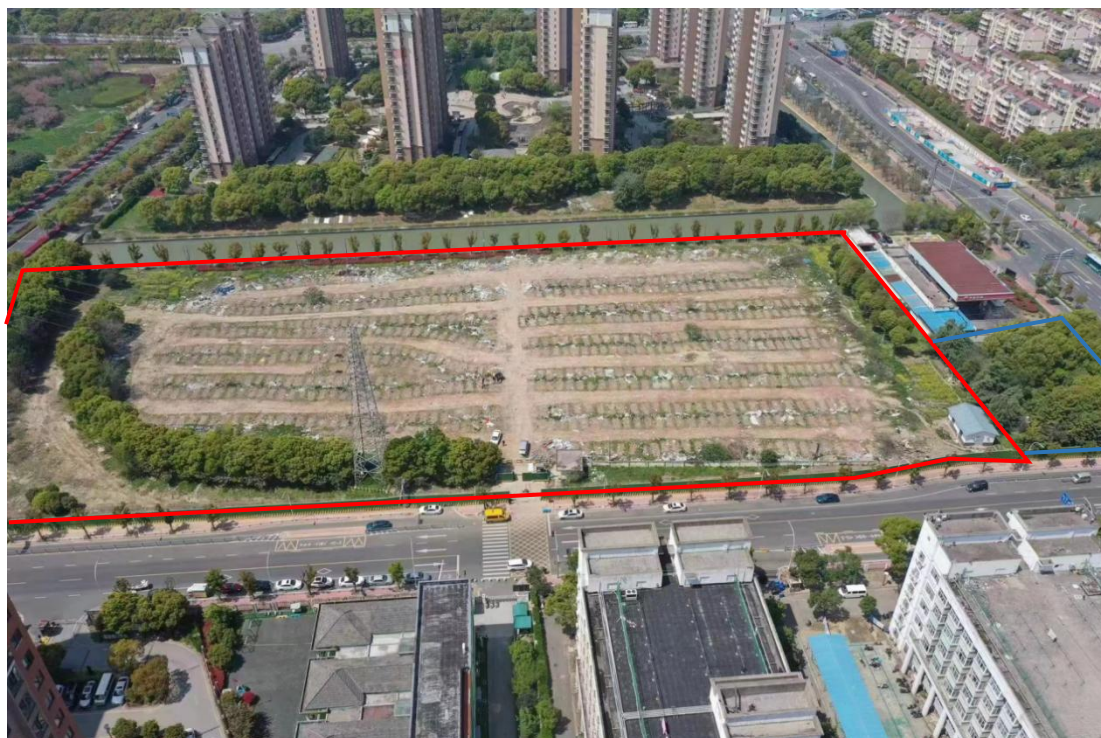
图 2.2-1 施工前原地貌航拍图（2022 年 12 月）
