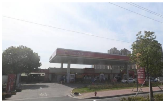
(d) 中国石油扬东路加油站
