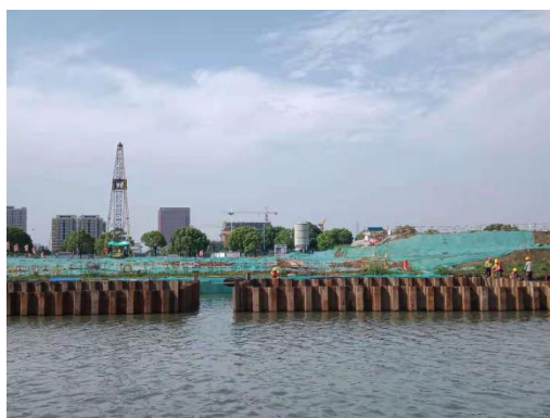
水中围堰施工现状
