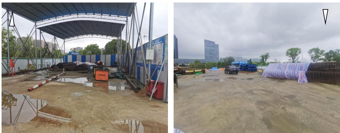
图1-20 施工生产区现场图
