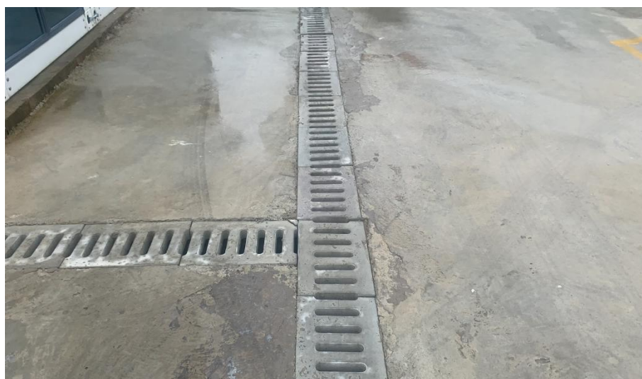
图3-5 办公生活区临时排水沟
