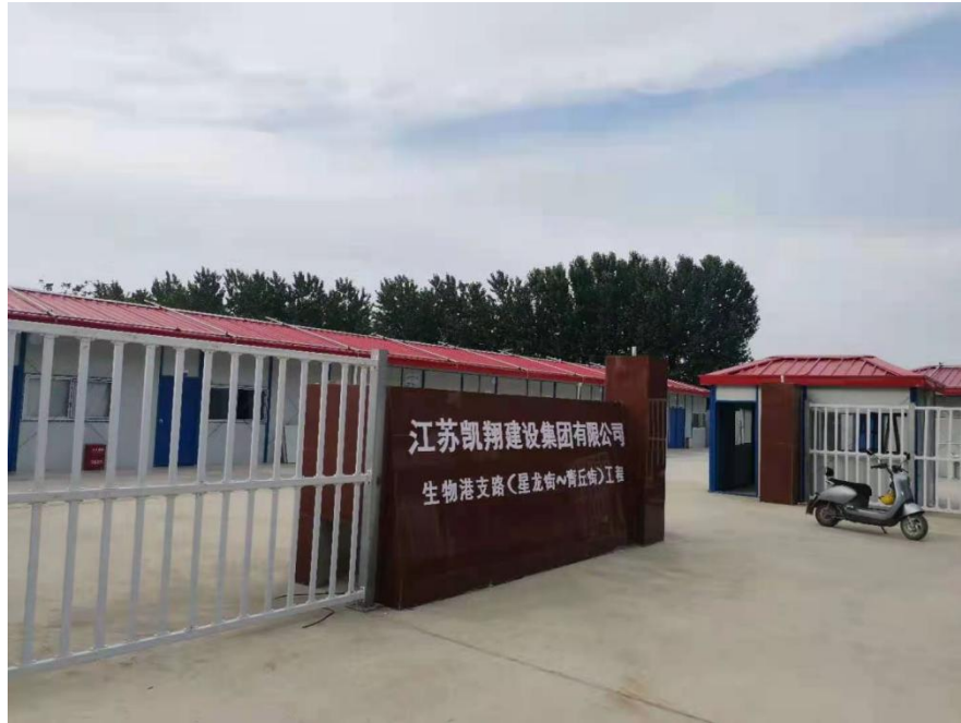
图1-16 施工生产生活区现场图
