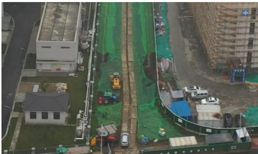
图 1-2 道路工程施工现状（2021.05）
